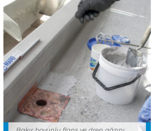
Bakır boyunlu flanş ve dren ağzını döşeme işlemi
