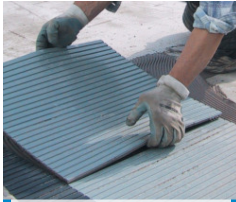
Çimento üzerine Granirapid ile kauçuk zemin kaplaması
