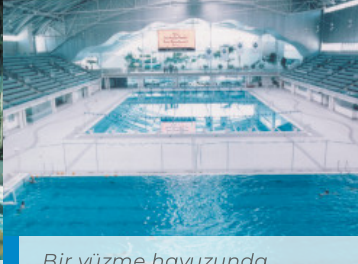
Bir yüzme havuzunda uygulanmış mozaik ve klinker örneği - Olympic Centre, Sydney (Avustralya)
