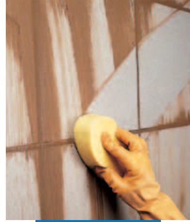
Süngerle bitirme işlemi uygulanan bir duvar
