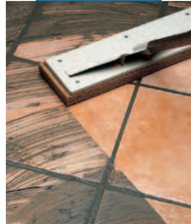
Tek pişirimli karo zeminin sünger fırça ile temizlenmesi
