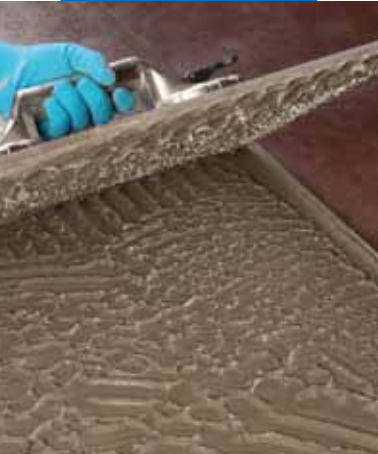
Karoların arka yüzünde kaplama miktarının kontrol edilmesi
