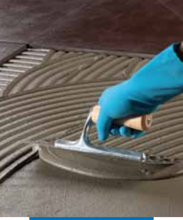
Keraflex Easy'nin zemine yuvarlatılmış yarım ay taraklı mala ile uygulanması
