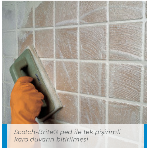
Sünger ile tek pişirilmiş karo duvarın bitirilmesi
