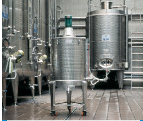
Derz dolgusu yapılmış şarap mahzeni zemini
