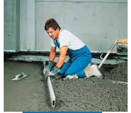
Düz kenarlı mastarın kullanılması
