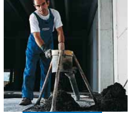
Mapecem karışımının hazırlanması
