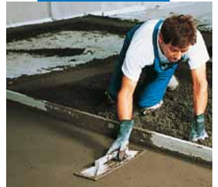
Mapecem şapın düzeltilmesi
