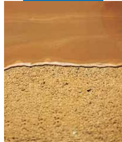
Mapecem şapın, kendiliğinden tesviye olan yüzey düzeltme bileşeni Ultraplan ile bitirilmesi
