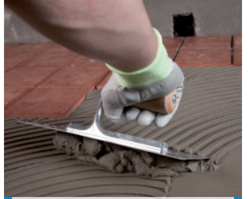
Su yalıtımı Mapelastix ile sağlanmış bir teras Granirapid uygulanması
