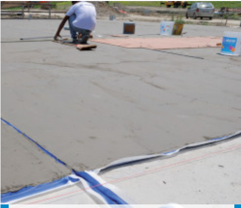
Şapların su yalıtımının Mapelastix ve Mapeband ile yapılması
