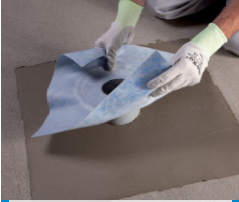
Drain Vertical'in Mapelastix üzerine uygulanması
