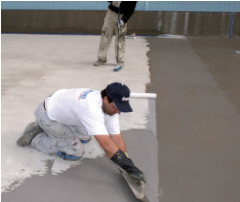
Bir yüzme havuzunun su yalıtımının Mapelastix ile yapılması
