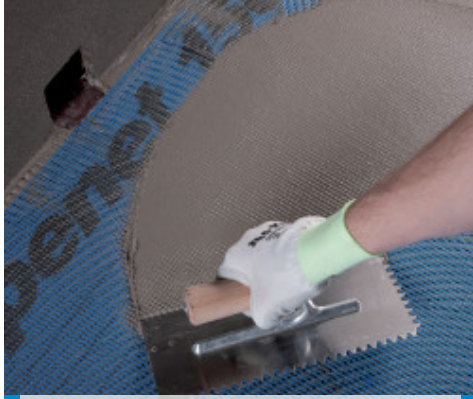
Mapelastix'in Mapenet 150 üzerine uygulanması
