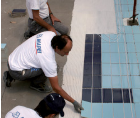
Bir yüzme havuzunda Mapelastix üzerine seramik karo uygulanması
