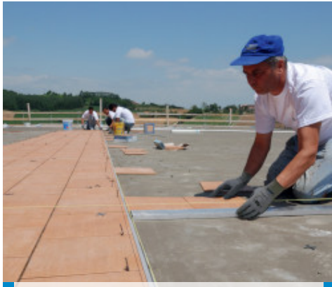
Kerabond + Isolastic ile seramik uygulaması
