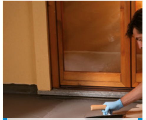
Terasların su yalıtımının mala ile yapılması
