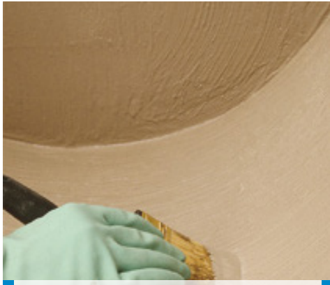
Detayların su yalıtımının fırça ile yapılması
