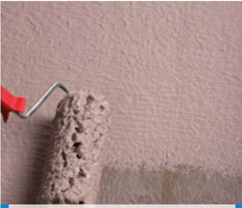
Terasların su yalıtımının rulo ile yapılması
