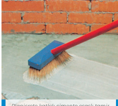
Planicrete katkılı çimento esaslı tamir harcının uygulanması
