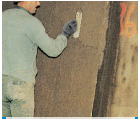
Planicrete katkılı çimento sıva - Ville Marie otoyol tüneli, Montreal, Kanada
