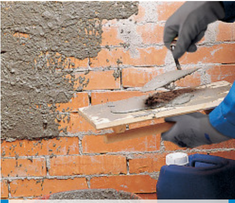
Planicrete katkılı harç ile zemin hazırlama
