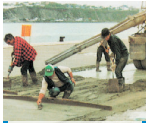
Planicrete katkılı çimento esaslı şap - Vieux Limanı, Quebec, Kanada
