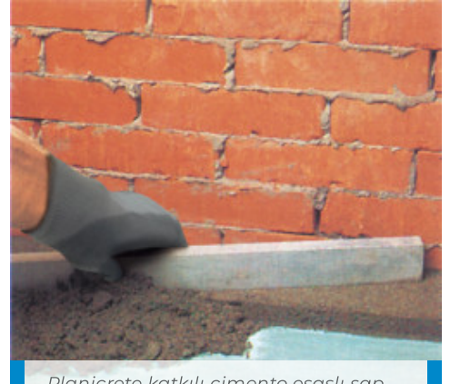
Planicrete katkılı çimento esaslı şap uygulaması
