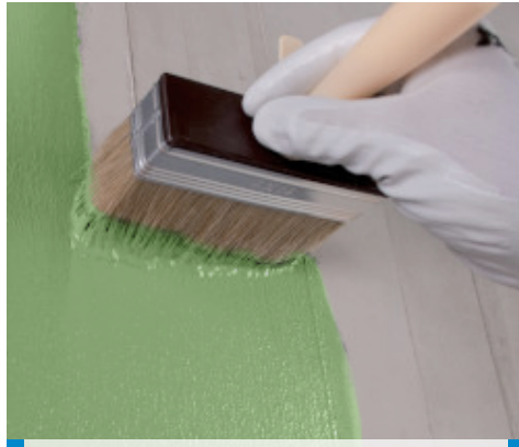
Beton üzerine fırça ile Primer AG uygulanması
