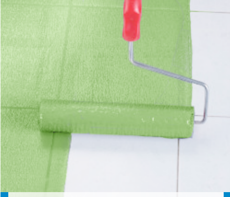
Mevcut terrazzo zemin üzerine rulo ile Primer AG uygulanması
