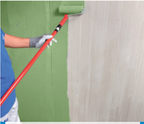
Beton üzerine rulo ile Primer AG uygulanması
