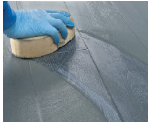
Derzlerin sert selüloz bir süngerle temizlenmesi ve bitirilmesi
