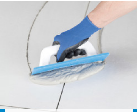
Mermer efektli porselen karolar üzerine kauçuk mala ile Ultracolor Plus yayılması
