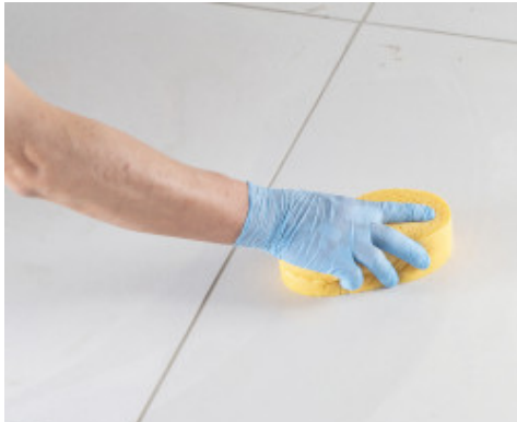
Derzlerin sert selüloz bir süngerle temizlenmesi ve bitirilmesi
