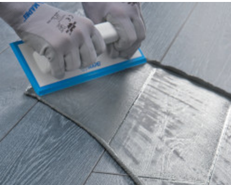
Ultracolor Plus'ın ahşap efektli porselen karolar üzerine kauçuk mala ile yayılması
