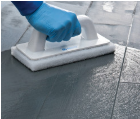
Derzlerin (Ürün yarı sertleşmişken) Scotch-Brite sünger ile temizlenmesi
