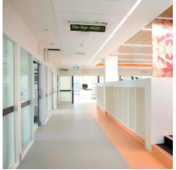
Ultraplan ile tevsiyeye edilmiş bir yüzeye linolyum yerleştirme örneği - Victorian Comprehensive Cancer Center - Melbourne - Avustralya
