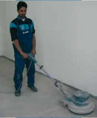
Ultraplan Eco uygulanmasından önce perdah makinesi ile parlatma yapılması - Mirabello anaokulu - Cantù (Como) - İtalya
